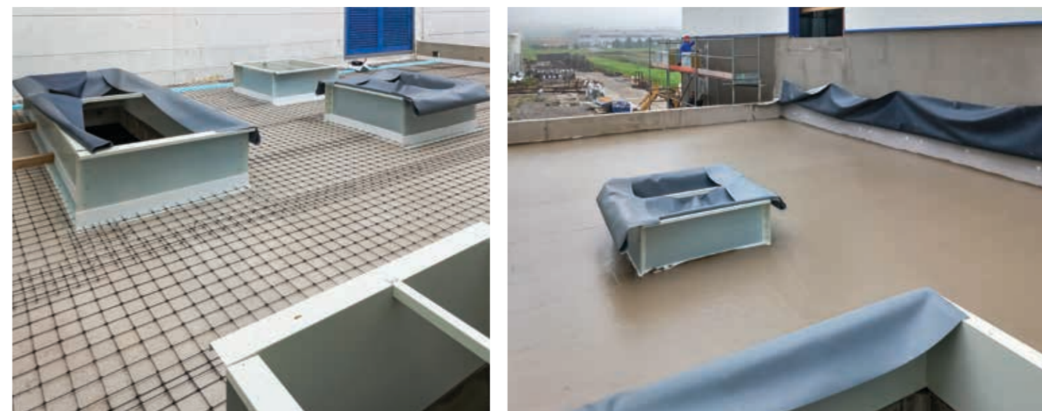
Obr. č. 14, 15 – aplikácia FC 500RF pre vytvorenie spádovej vrstvy strechy (priemyselná hala Künz Kechnec)
