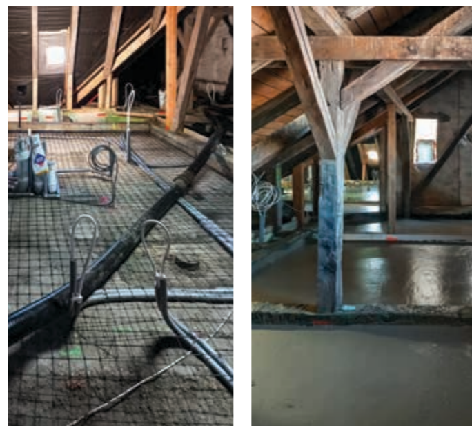
Obr. č. 12, 13 – FC 400- výplňová vrstva FC pri rekonštrukcii podkrovných priestorov (Košice)
