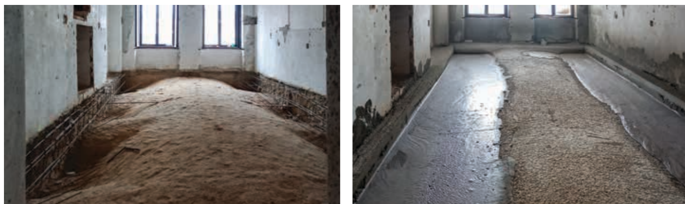
Obr. č. 6, 7, 8 – Podkladová vrstva FC 400 pod systémom podlahového vykurovania (novostavba / rekonštrukcia RD)
