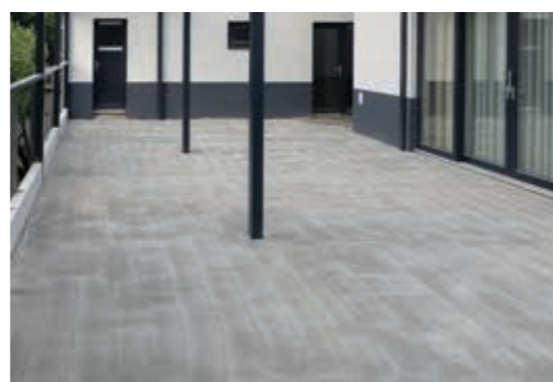
Obr. č. 18, 19 – Aplikácia FC 600 – vyrovnávací poter zimnej terasy na nosníkoch (reštaurácia Hlinné)
