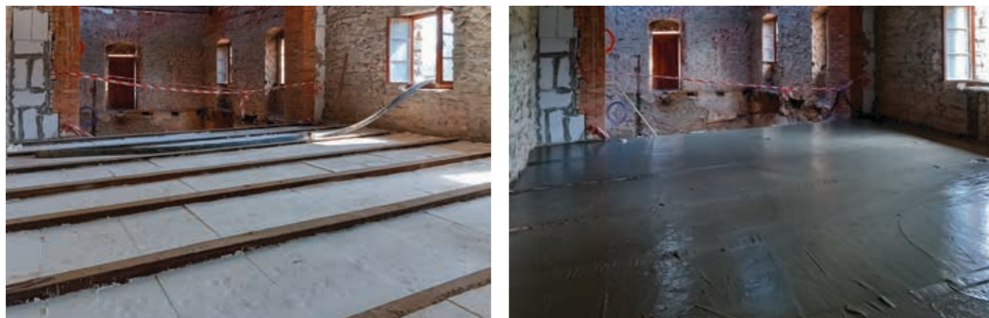
Obr. č. 16, 17 – Aplikácia FC 900 – vyrovnávací poter stropnej konštrukcie z FC – (kaštieľ Markušovce)
