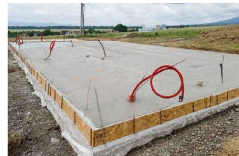
Obr.č.3 - POROBASE - hotová konštrukcia plošného základu v oboch vrstvách (podkladová vrstva z penobetónu FC 500CB hrúbky 200 mm a betónová základová doska v hrúbke 150 mm). Konštrukcia bola realizovaná spoločnosťou COMPSTAV, s.r.o.
